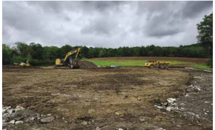
Chantier en cours à BENEJACQ
