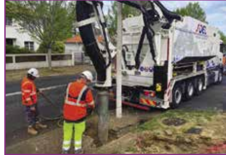
Enfouissement rue Louis de Foix à BAYONNE
