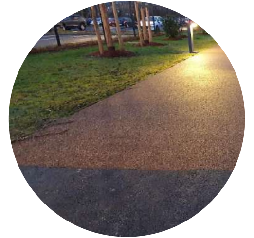
ENROBÉ NOIR HYDRO-LAVÉ
